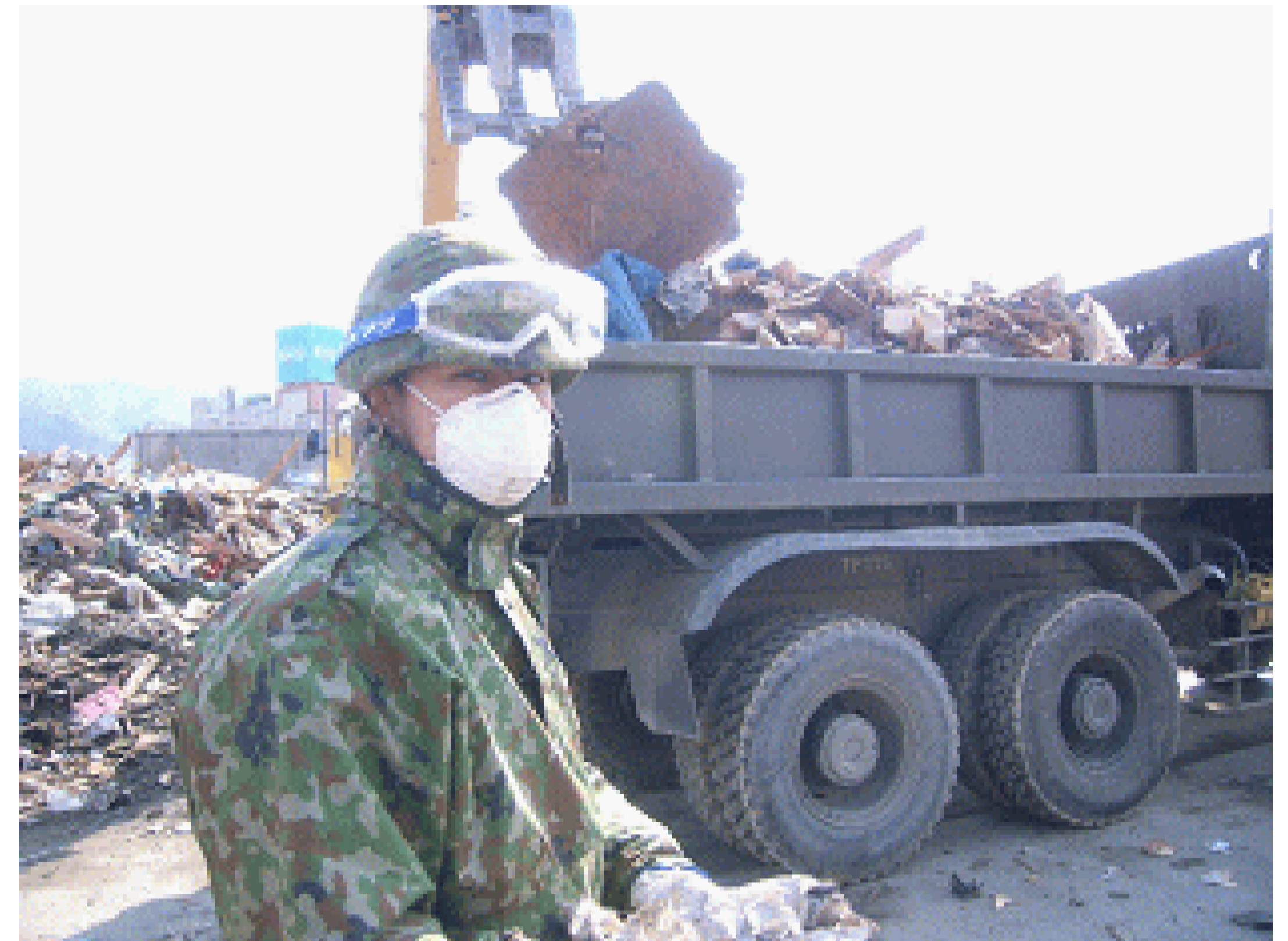
瓦礫の除去作業中
